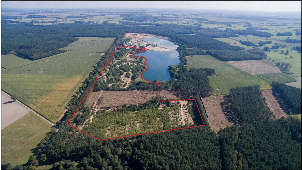
Abb. 6: Luftaufnahme des B-Plangebietes, Blickrichtung Ost (WÖHLBIER 2017)
